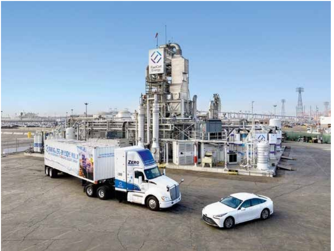
Abb. 6: FuelCell Energys Tri-Gen-System am Hafen von Long Beach [Quelle: FuelCell Energy]
