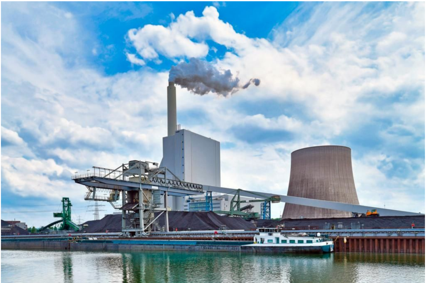
Kohlekraftwerk von EnBW in Karlsruhe: »Der Ausstieg bis 2028 ist hochambitioniert, aber möglich«
