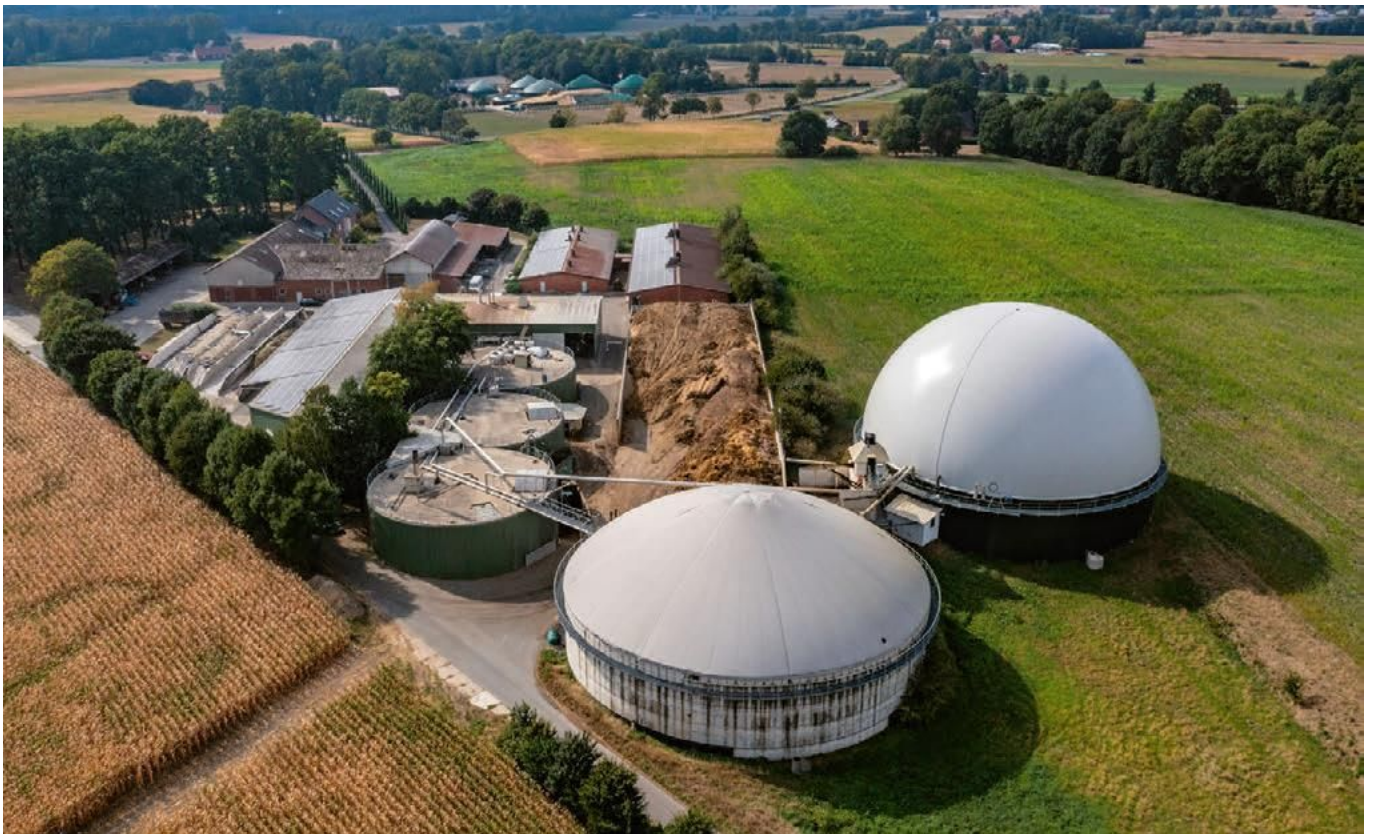
Eine Lösung fürs Land: Eine Biogasanlage nahe Delbrück in Nordrhein-Westfalen heizt Eigenheime in der Umgebung. Jochen Eckel/SZ/laif
