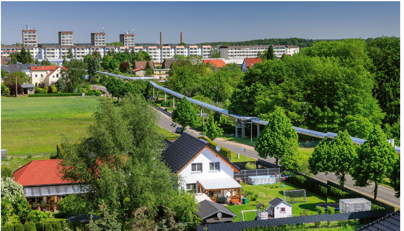
26 Kilometer Leitung: Mehr als 200 Gebäude in Spremberg (Brandenburg) werden vom Kraftwerk Schwarze Pumpe mit Fernwärme beliefert. Rainer Weisflog
